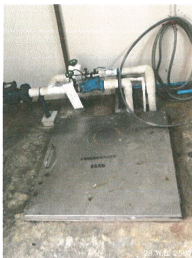
รูปภาพที่ 2.42 ถังเก็บน้ำใต้ดิน
